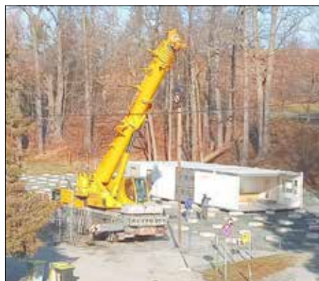
Aufsetzen der Container
