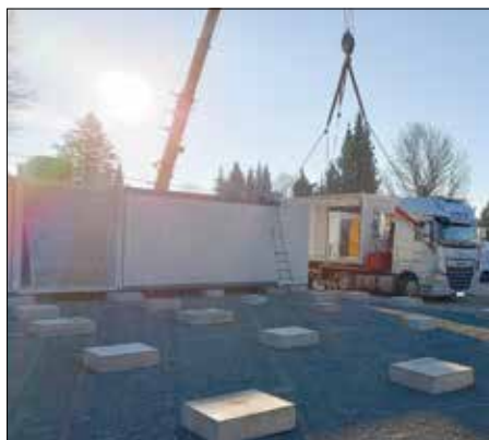
Aneinanderfügen der Container
