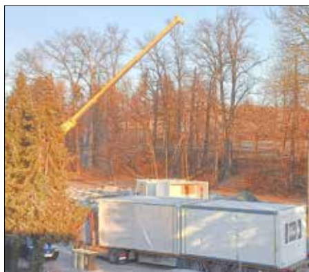
Die ersten Container kommen..
