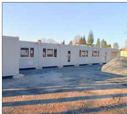
Aufsetzen der Container
